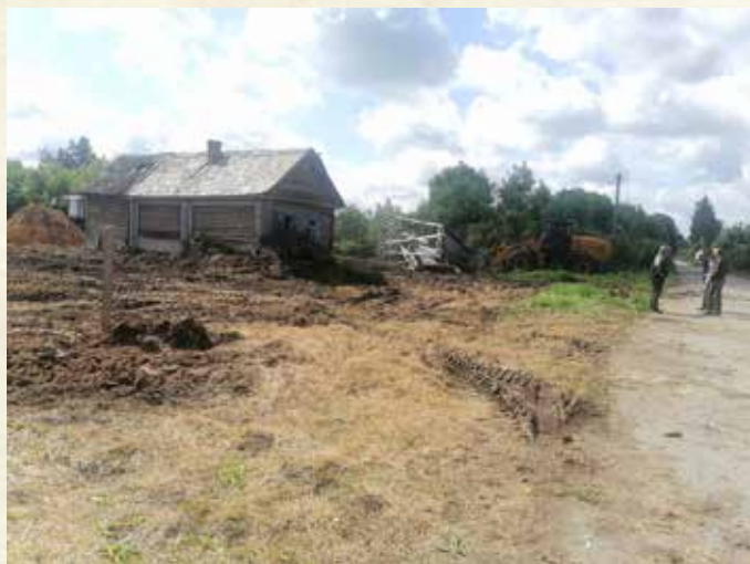
Снос хозяйственной постройки (июнь 2025 г., Ветковский район, Светиловичский сельсовет, аг. Светиловичи)
